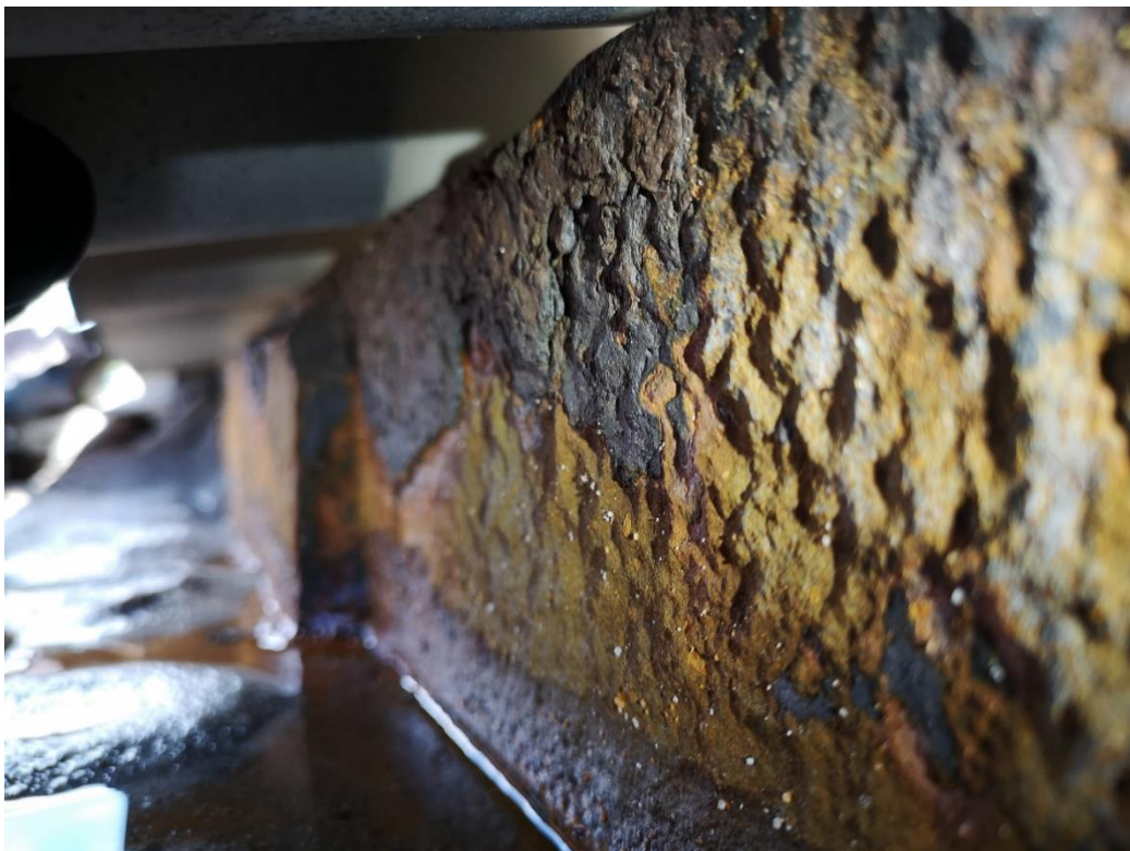
Korozní poškození úžlabí pátevního nosníku
