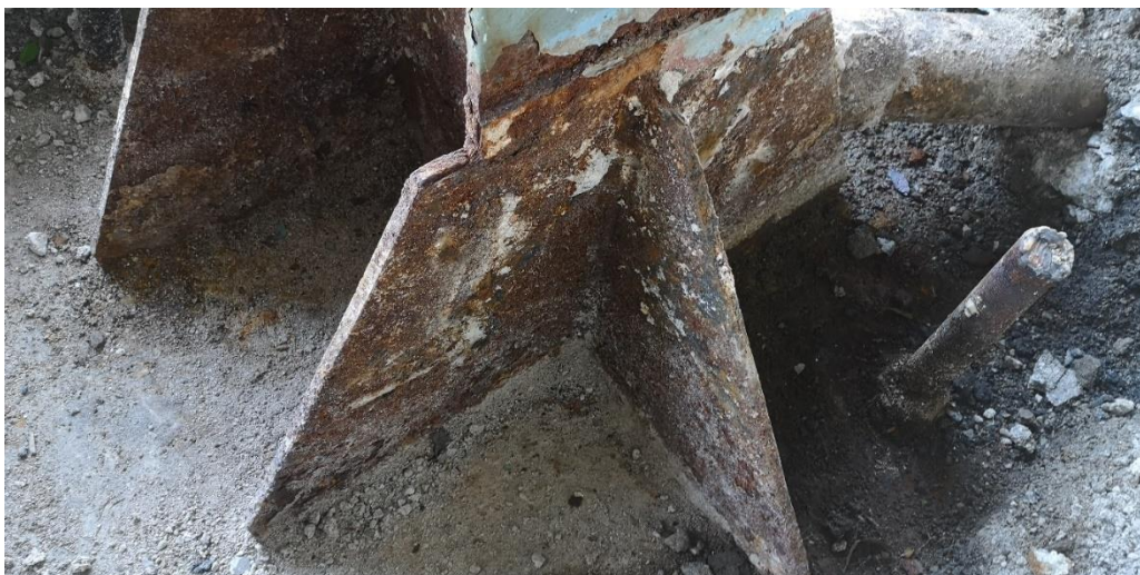
Patní oblast sloupu před tryskáním
