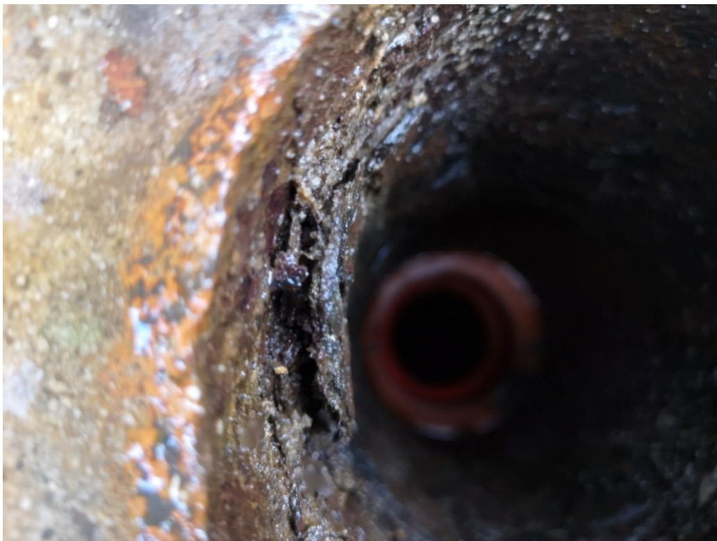
Masivní hloubková koroze v prostupu svodu
