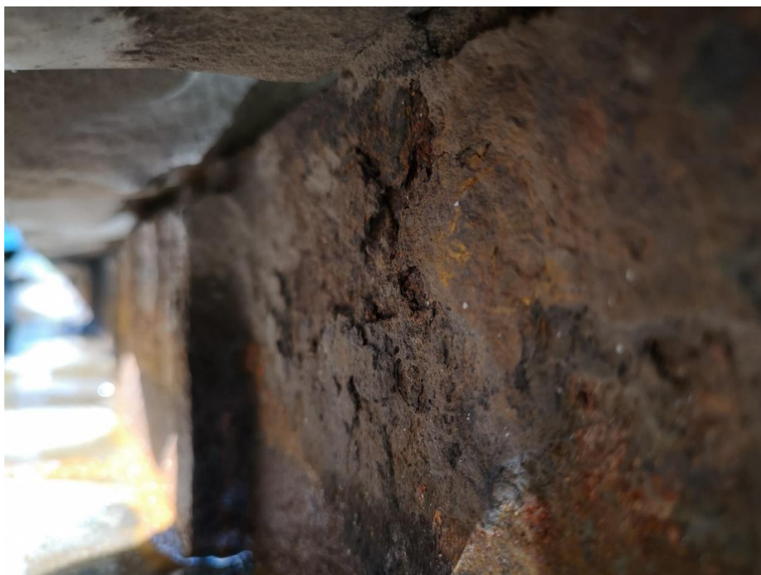
Korozní poškození úžlabí páteřního nosníku
