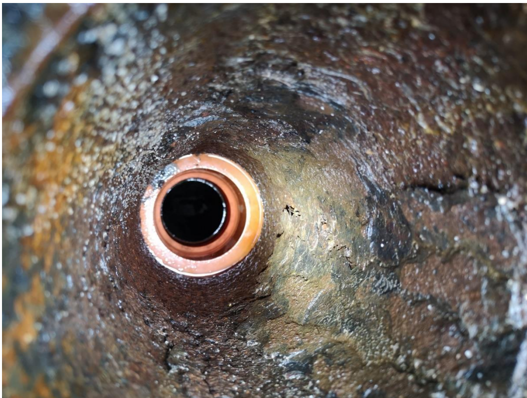
Masivní hloubková koroze v prostupu svodu
