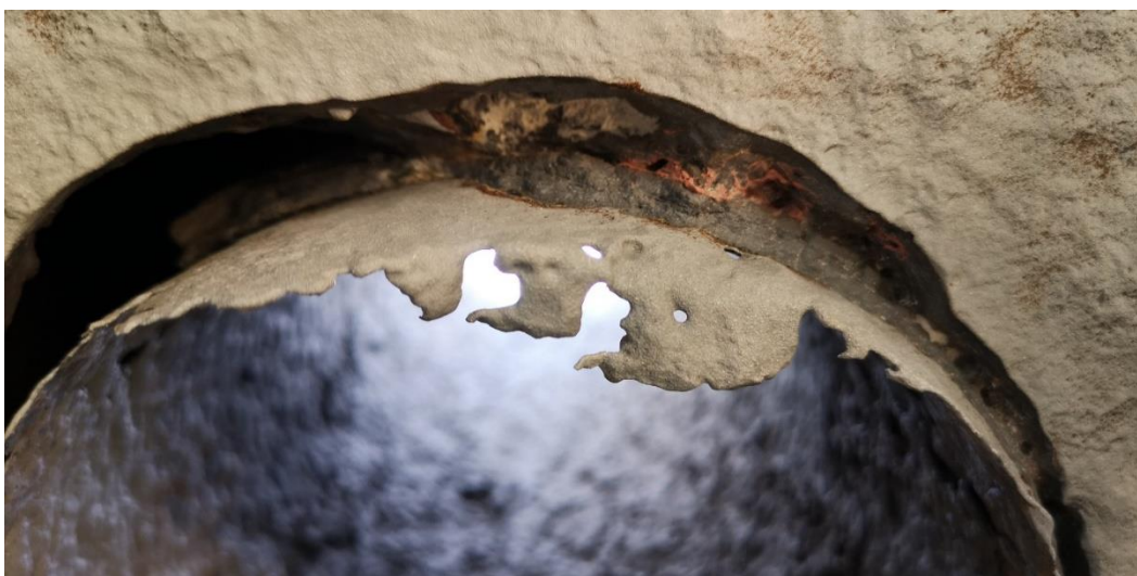
Prostup pro svod, spodní líc – korozní úbytek ~100%
