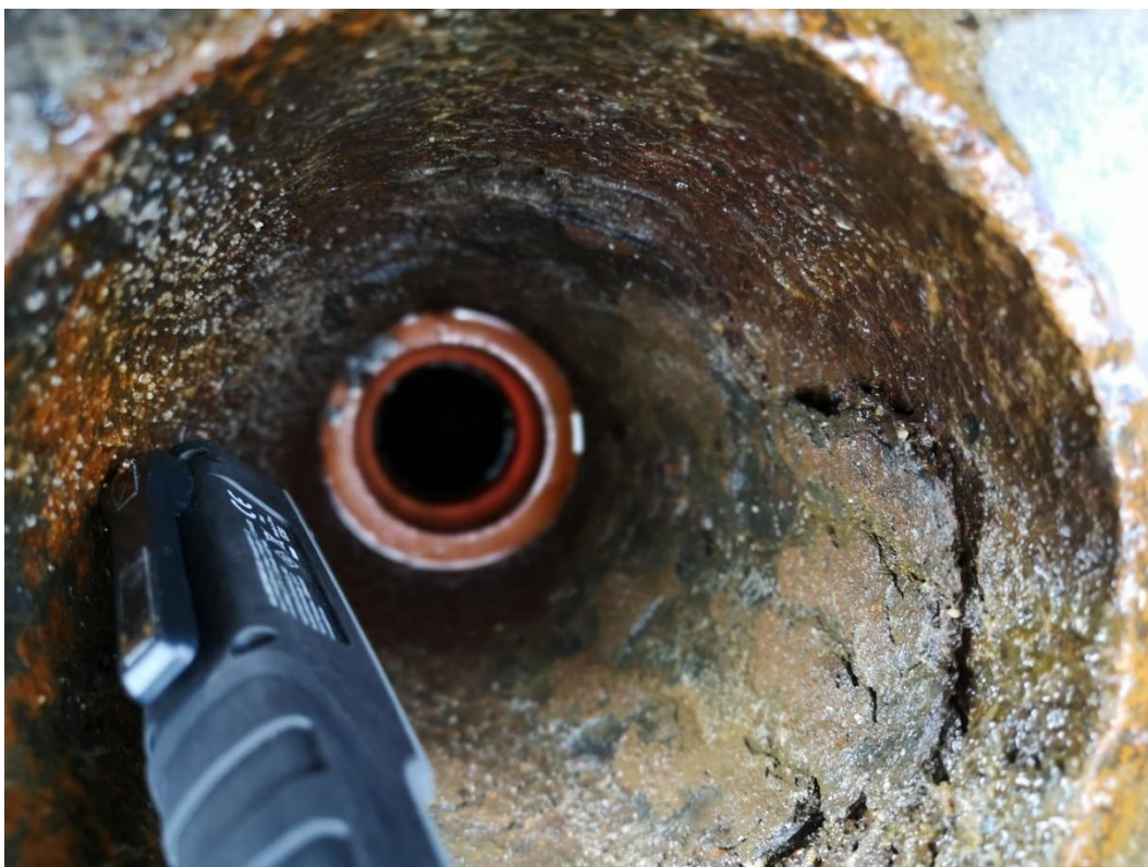
Masivní hloubková koroze v prostupu svodu
