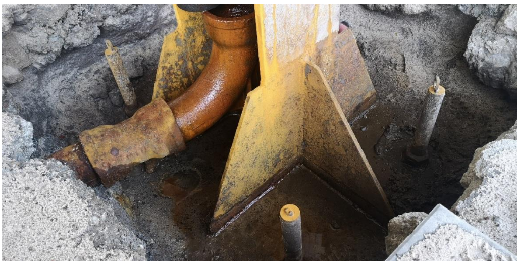
Patní oblast sloupu po tryskání
