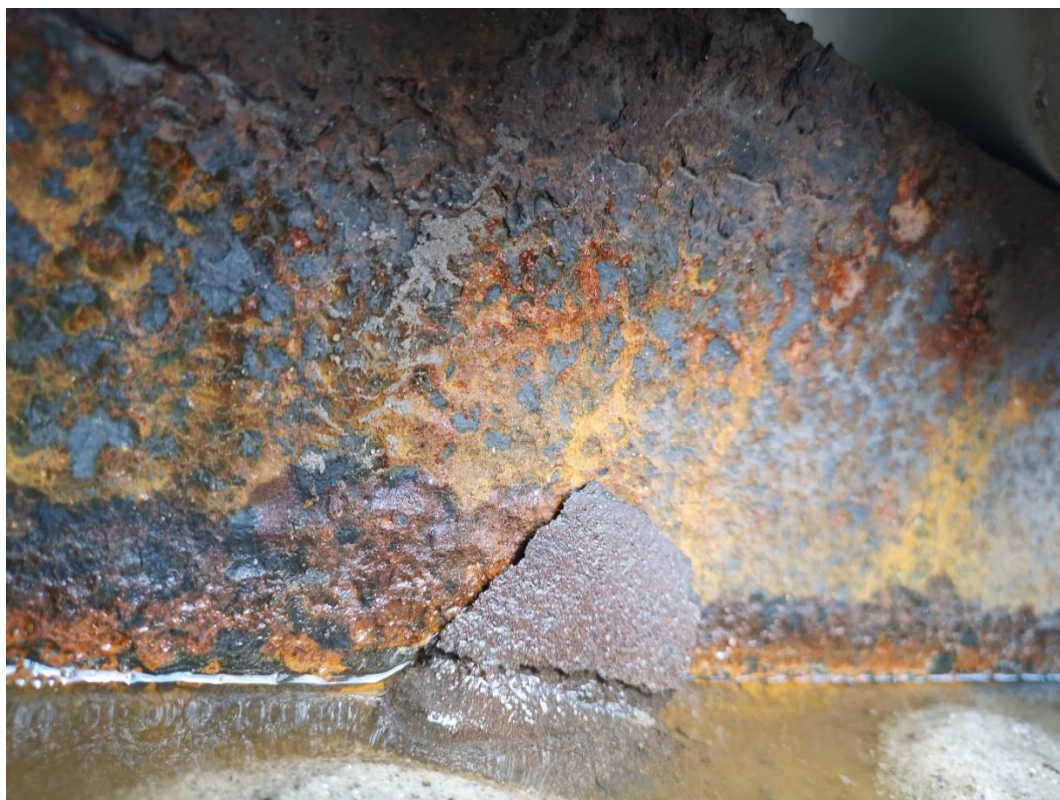
Korozní poškození úžlabí páteřního nosníku
