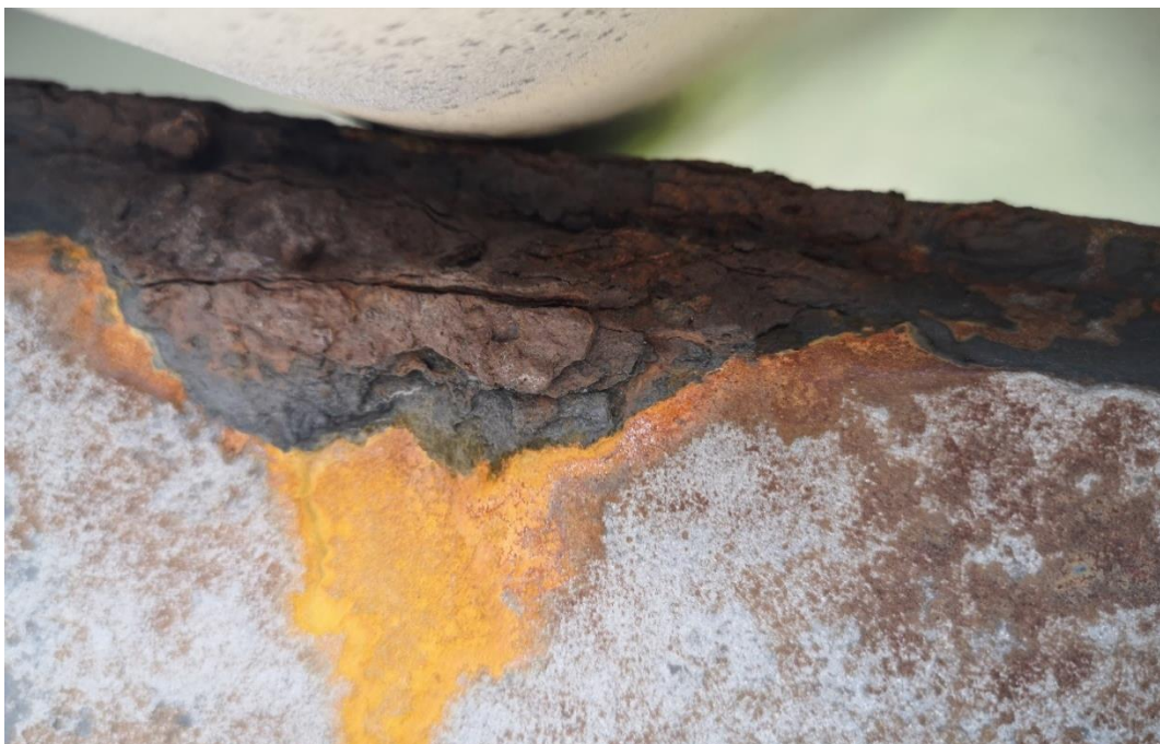
Štěrbínová koroze ve spáře svařovaných plechů horního úžlabí (pod krytinou)
