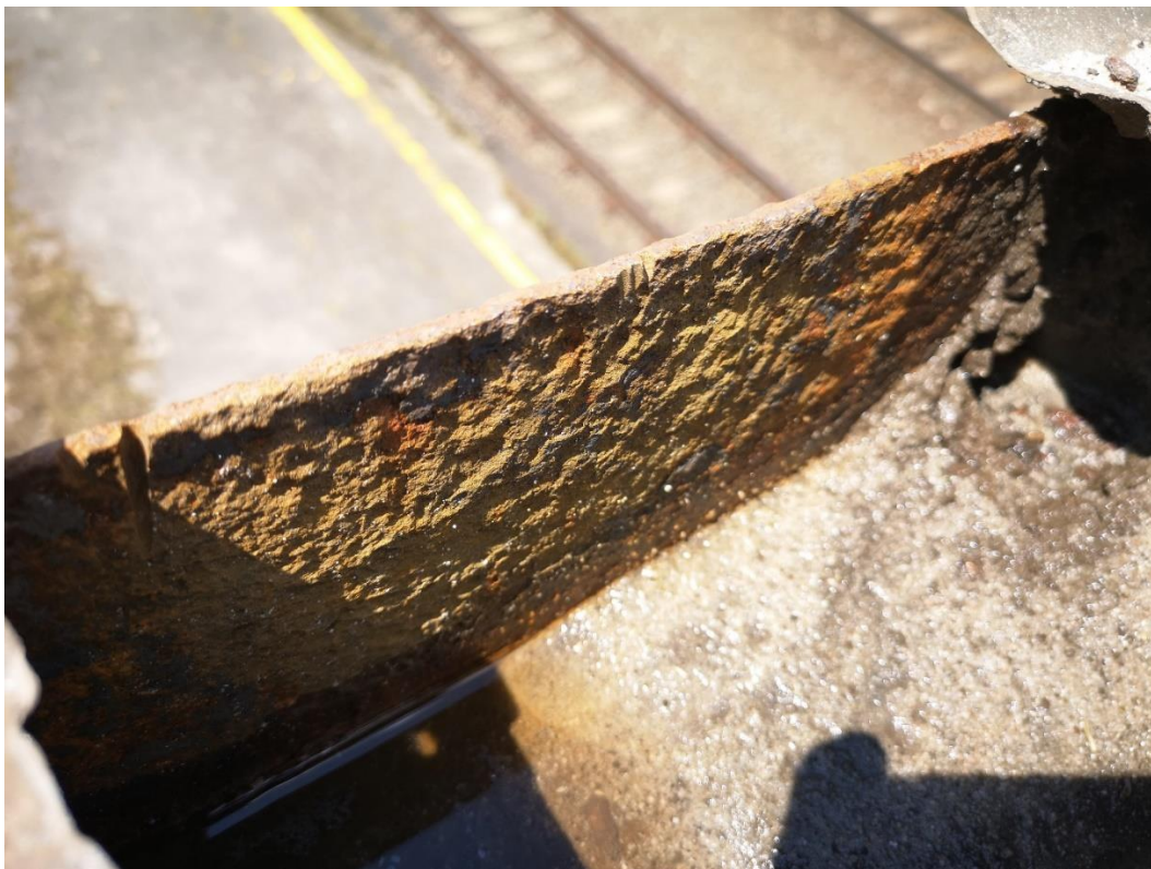
Korozní poškození úžlabí páteřního nosníku
